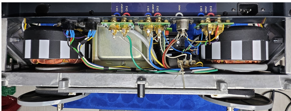
Foto 9 - Korrekt montierte Codierstreifen auf linkem und rechtem Rotor.
