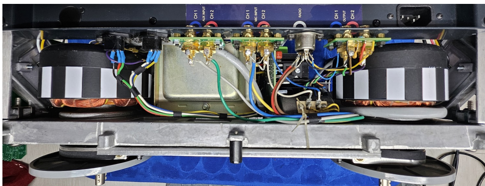
Photo 9 - Bandes de codage correctement installées sur les rotors gauche et droit.
